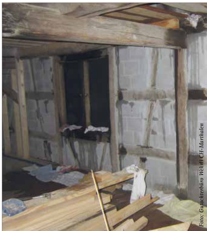
Schlagregen auf der Innenseite einer Riegelwand.
