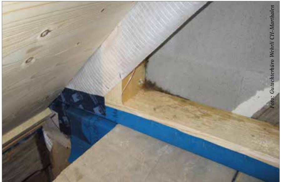
Durchgängige Luftdichtung am Deckenaufleger
