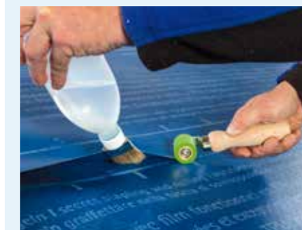
Abb. 21: Verschweißung von Unterdachbahnen, mittels Quellschweißmittel oder Heißluftföhn werden die Funktionsschichten überlappender Bahnen homogen verschweißbar
