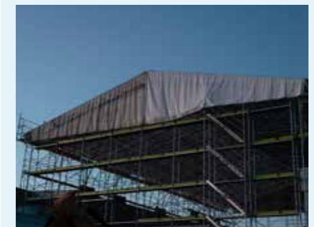
Abb. 3: Einhausen bzw. Notdach
