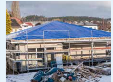
Abb. 2: Abplanen eines Daches
