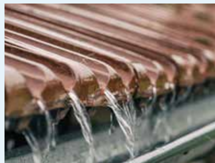
Abb. 7: Witterungsschutz des fertigen Daches wird hauptsächlich durch die Eindeckung erzeugt. Dennoch kann Wasser z. B. bei Schlagregen hindurchtreten.
