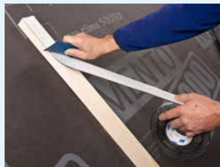
Abb. 6: Perforationssicherung: Abdichtung der Durchdringungen durch Befestigungsmittel der Konterlatte
