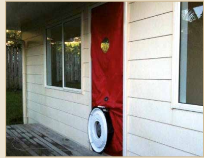
Figs. 61, 62, 63, 64. Blower Door test
