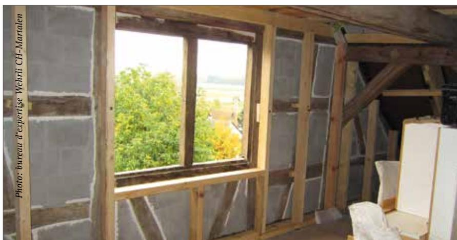
Enduit intérieur sur mur à colombages, amélioré : les joints de raccord entre maçonnerie et poutre ont été soigneusement optimisés, de sorte que la pluie battante ne puisse plus pénétrer si facilement.
