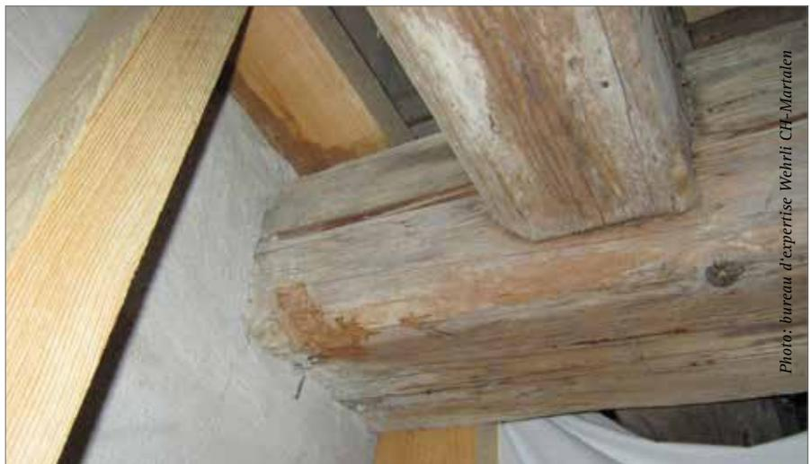
Poutre fissurée : les poutres fissurées peuvent être à l'origine de fuites
