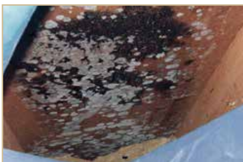
Aparición de moho por condensación
