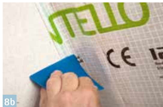
CONTEGA PV Sikrer pålitelige, lufttette skjøter mot underliggende flater som skal pusses, for alle bygningstyper.
