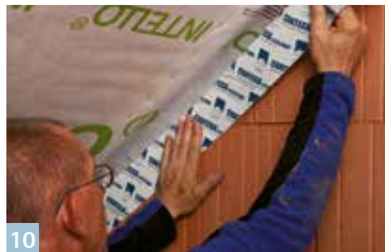
CONTEGA SOLIDO SL Skaper klebende forbindelse til mineralske underlag, kan pusses over; sikrer pålitelige, lufttette skjøter mot underliggende flater som skal pusses, for alle bygningstyper.
