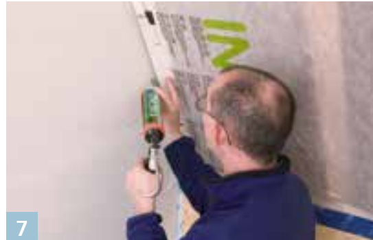
ORCON F Gir pålitelige skjøter mot grove eller mineralske bygningsdeler.
